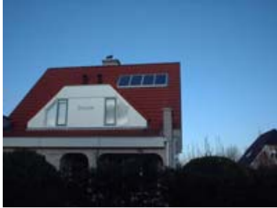
Locatie: Woonhuis in Houten Panelen: 4x Solarworld SM150 indeksysteem Vermogen: 600 W/piek Omvormers: 4x NKF OKE4
